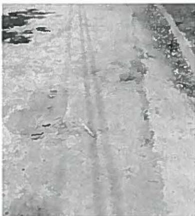
Empedrado fraguado con superficie terminada dañado pero según el Sr. Alcalde fue obra donada por el realizador, además es un sistema de poca durabilidad.
