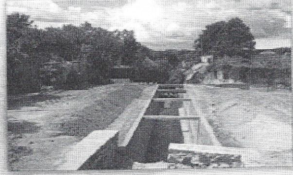
Fig. 2 Septiembre/14, situación actual del proyecto en ejecución.
