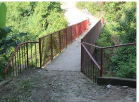
PASARELA LOS GOCHEZ
