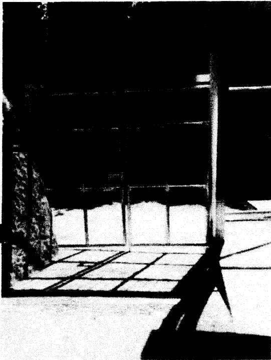
PORTON DE ACCESO DE MALLA CICLON Y TUBO GALVANIZADO DE 2".
