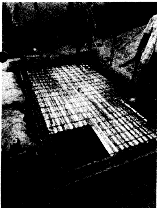
REFUERZO PARA LOSA DE CONCRETO DE FOSA SEPTICA.
