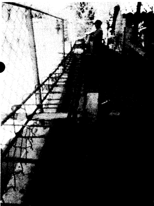
ARMADO DE HIERRO Y EXCAVACIÓN PARA SOLERA DE FUNDACIÓN
