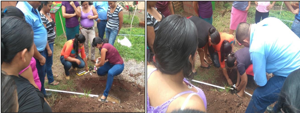
Haciendo pequeñas reparación
