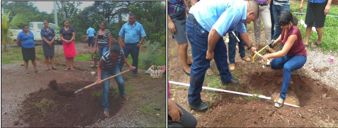
Realizando conexión domiciliar
