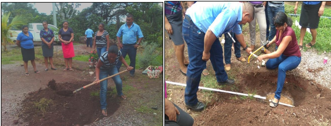
Realizando conexión domiciliar
