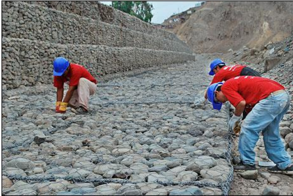
Figura 8. Instalación de la coraza de gaviones
