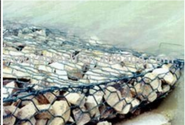
Figura 9. Resultado de la instalación en talud
