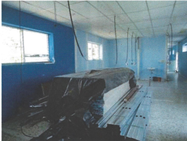
Desmontaje de sanitarios
