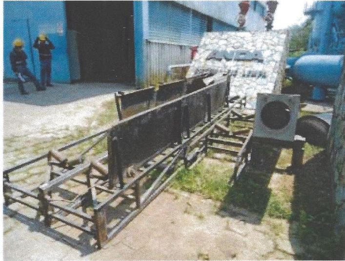
Desmontaje de equipos.
