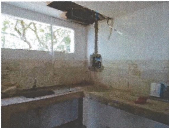
Demolición de enchape y desmontaje de cubierta de techo
