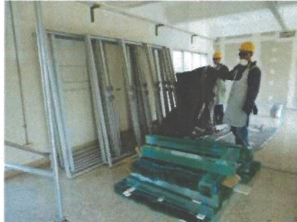
Trabajos de impermeabilización de losa y suministro de ventanas en oficinas (marcos de aluminio y celosías de vidrio)
