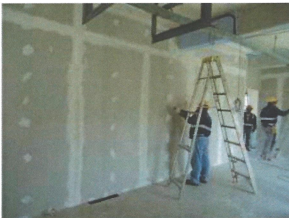
Trabajos de tablaroca e instalación de puertas y ventanas en oficinas
