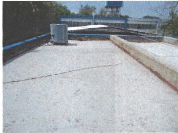
Secuencia de los trabajos de escarificado en la losa de techo para su posterior impermeabilización
