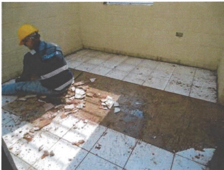
Demolición de piso Casa Club
