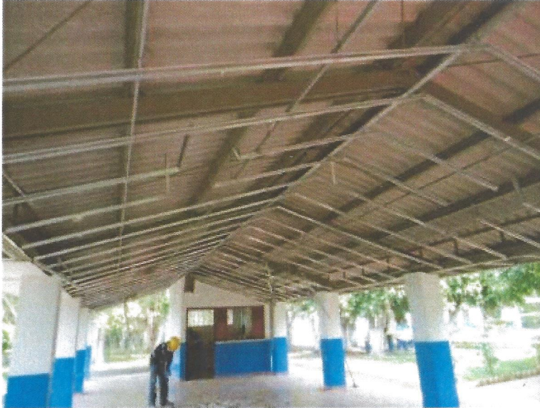
Desmontajes en salón de usos múltiples (recinto II)
