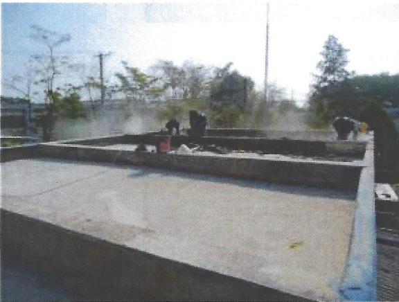
Secuencia de los trabajos de escarificado en la losa de techo para su posterior impermeabilización
