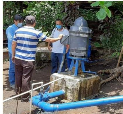
Condición de los equipos electromecánicos: El equipo electromecánico presenta buenas condiciones de operación, abasteciendo el tanque y comunidades con presión y caudal suficiente para satisfacer la demanda de las dos comunidades que se benefician del sistema. Según nos informan los operadores.
