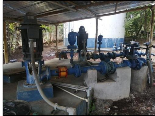
No todos los manómetros en el árbol de descarga de la planta de bombeo funcionan correctamente. En la línea de impelencia que abastece a San Mariano se ha realizado by pass a dos kilómetros para abastecer el tanque Cruz Verde de capacidad 150 m<sup>3</sup>. Cuando se abre la válvula del by pass, se cierra la válvula para San Mariano.
