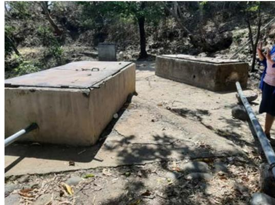
también cuentan con un equipo de bombeo de 15 HP para llevar el agua hacia un tanque y luego distribuirla a la comunidad, ambos sistemas cuentan con una línea de impelencia de 3", los árboles de descarga de ambos sistemas están en mal estado, el sistema de cloración está dañado y por ende no lo están utilizando, el muro frontal de la caja de captación presenta varias filtraciones en la base y los tableros eléctricos necesitan cambio de elementos.
