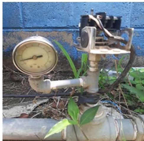
recomendó hacer el cambio de manómetro por uno de la misma escala con glicerina y sustituir el switch de presión para poder regular el paro y arranque automático.
