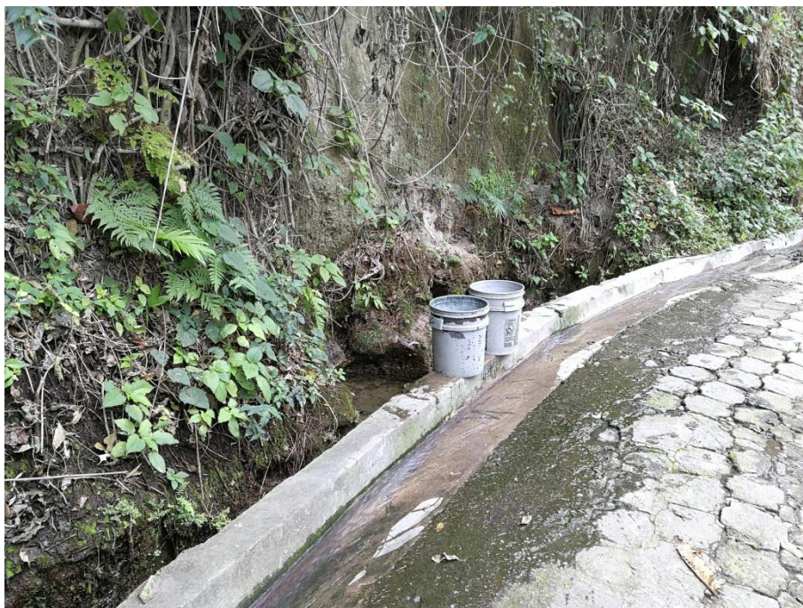
SE PUEDE OBSERVAR LA PRESENCIA CONSTANTE DE FLUJOS DE AGUA EN LA PARTE POSTERIOR DE LA ESTRUCTURA
