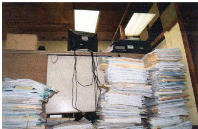
Filtración de aguas lluvias en instalaciones del Laboratorio de Control de Calidad
