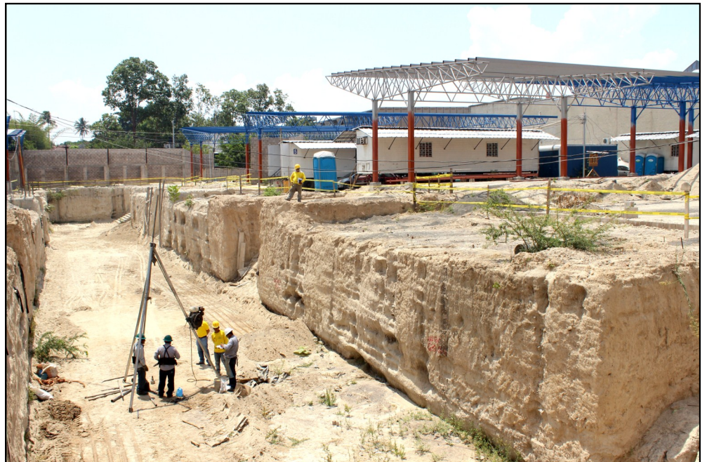
La empresa DISA ha tenido que demoler parte de la construcción del túnel peatonal y realizar pruebas de suelo, la semana pasada.
