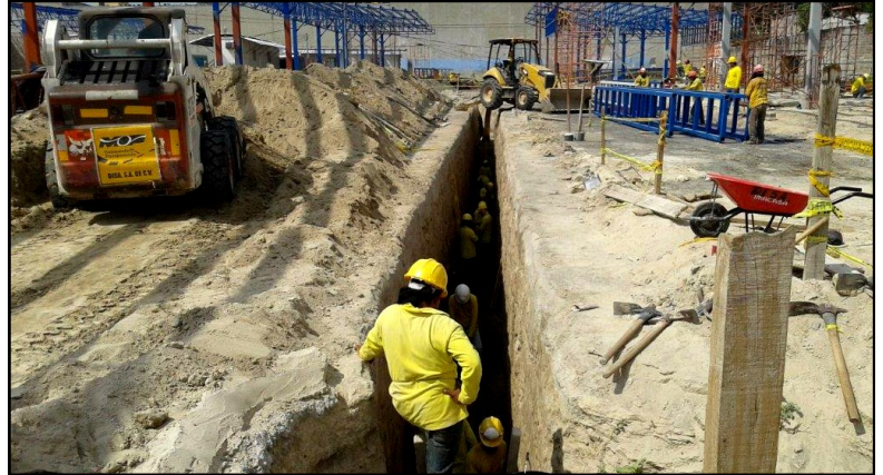
Obreros y técnicos de DISA trabajando en el sistema hidráulico de la Terminal.
