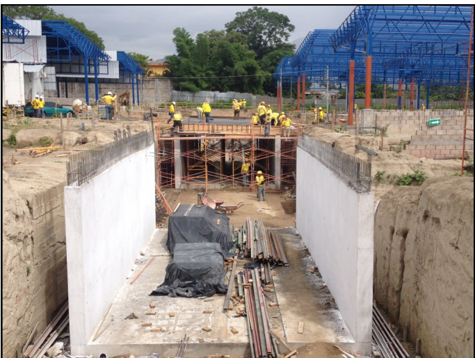
Perspectiva de oriente a poniente de la construcción del túnel peatonal de la Terminal de Integración del SITRAMSS.
