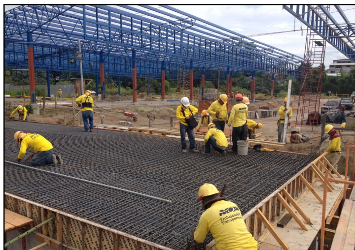
Obreros de DISA trabajando en armadura metálica donde se colará el concreto hidráulico en el techo del túnel que a la vez servirá como vial.
