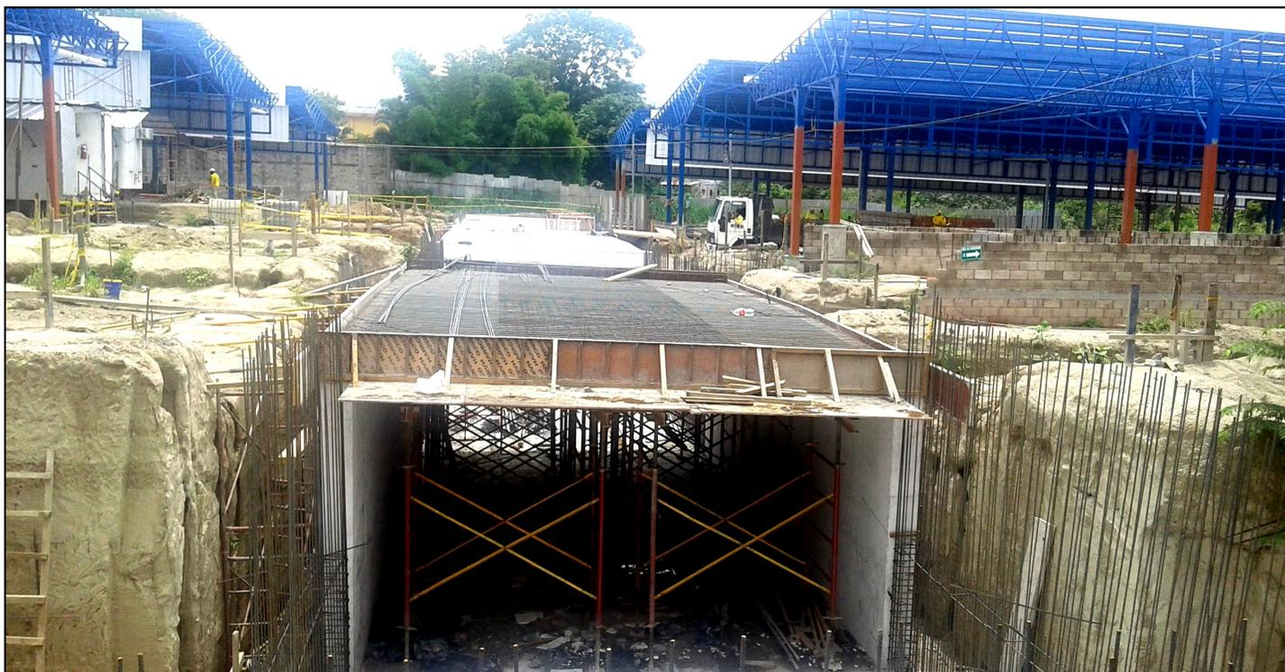
Vista de oriente a poniente de la construcción del túnel peatonal de la Terminal de Integración, estructura reforzada con un entramado de hierro para soportar el peso de los vehículos que circularán en cima del techo, el cual es parte de uno de los viales.
