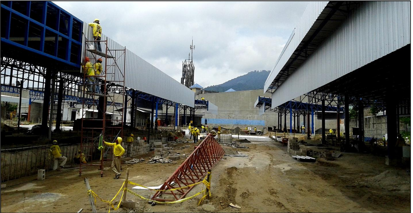
Vista de norte a sur de las estructuras metálicas de los techos del ala sur de la Terminal, donde se aprecia a los obreros trabajando en las facias que permitirán el resguardo de la lluvia y vientos de los usuarios del SITRAMSS.
