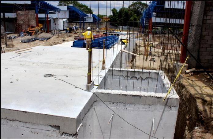
En la parte derecha de la fotografía se muestra uno de los cuatro cubos que sostendrán los elevadores en la Terminal de Integración.
