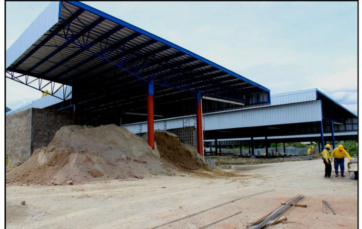
En la gráfica se muestran parte de los techos instalados sobre las estructuras metálicas que le darán cobijo a los andenes.
