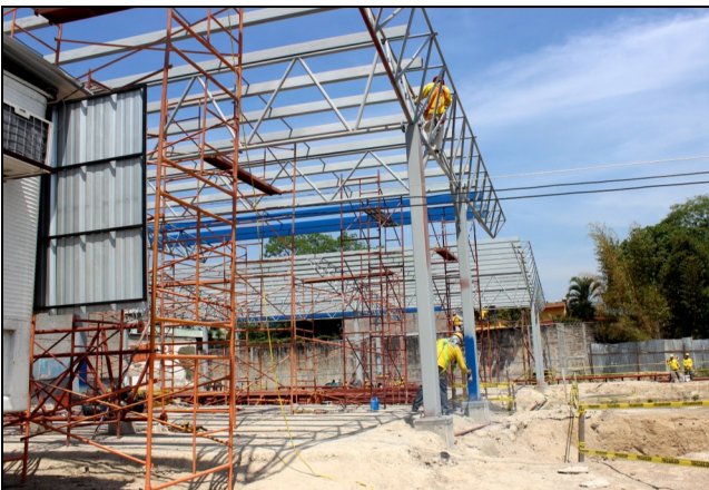
Obreros de la constructora DISA aplicando pintura a las estructuras metálicas de los techos de la Terminal.
