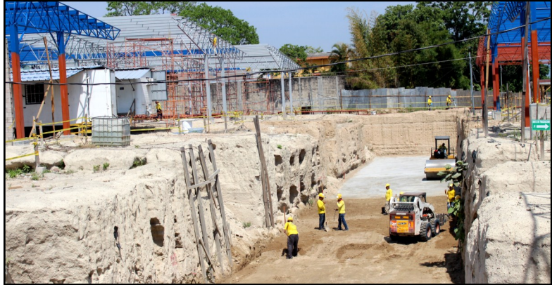
Obreros y técnicos de DISA trabajando en la cimentación del túnel peatonal, en la Terminal de Integración del SITRAMSS en Soyapango.
