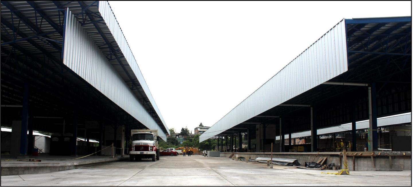
Vial por el cual circularán los autobuses dentro de la Terminal de Integración, como se puede observar en el lado izquierdo de la imagen el andén está elevado a 30 centímetros del vial para los alimentadores y en el lado derecho el andén está elevado a 90 centímetros para los autobuses articulados.
