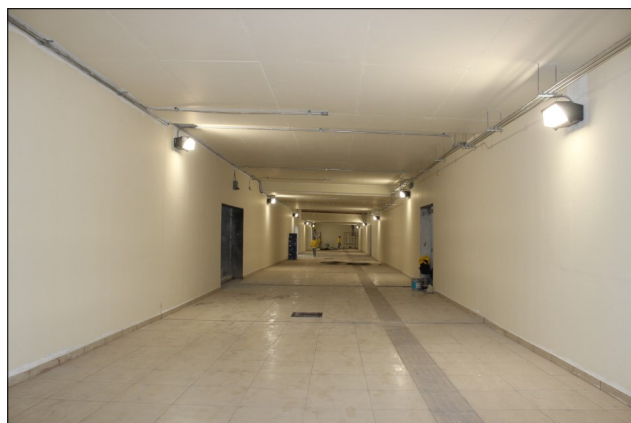
Túnel peatonal finalizado y con iluminación que atraviesa de oriente a poniente a la Terminal de Integración.
