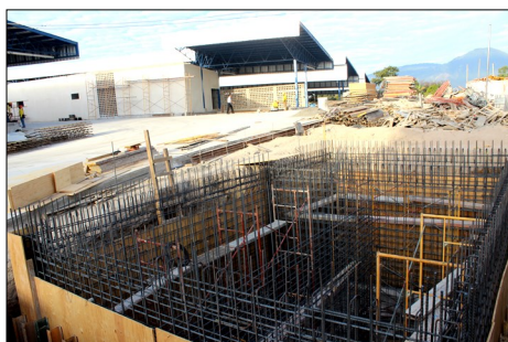
Construcción de la cisterna de agua potable al costado nororiental de la Terminal de Integración.
