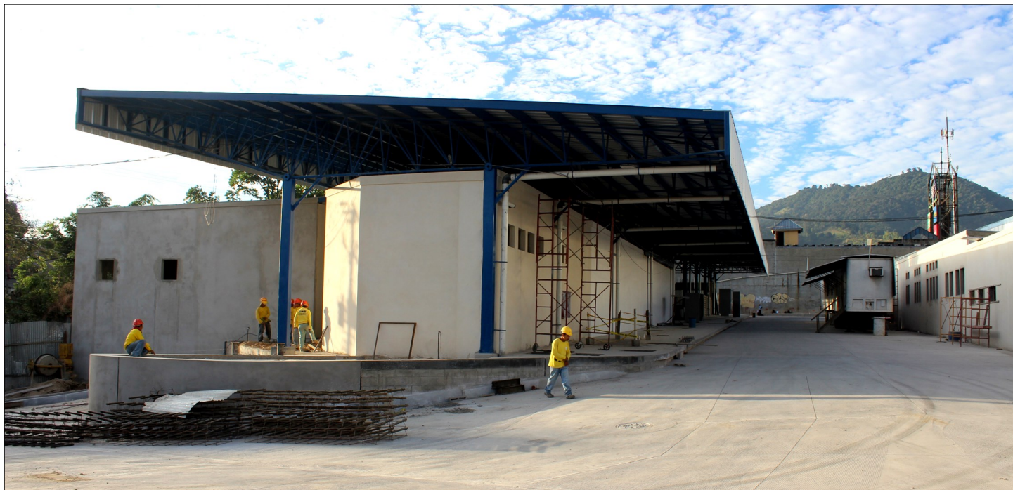
El Andén "A" de la Terminal es un edificio que albergará al Centro de Control del SITRAMSS y el ingreso peatonal de toda la estructura, así como los baños públicos.
