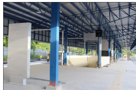
Áreas de acceso al túnel y zonas de espera de abordaje del Andén "D" de la Terminal de Integración.
