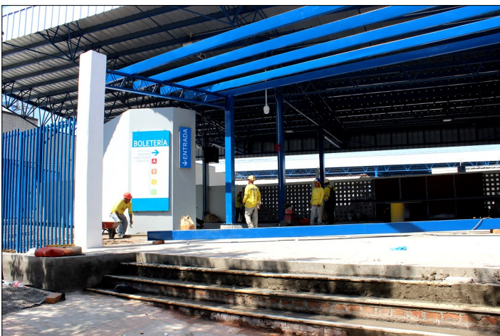
Entrada peatonal con orientaciones para la persona usuaria, frente a la Avenida El Rosario Sur.
