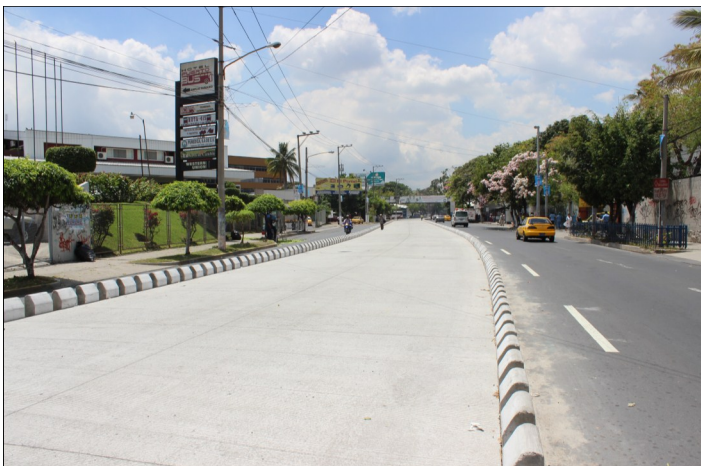
Sección del Tramo II frente al ISSS de Especialidades en la Alameda Juan Pablo II, donde se muestra la pista de concreto hidráulico
