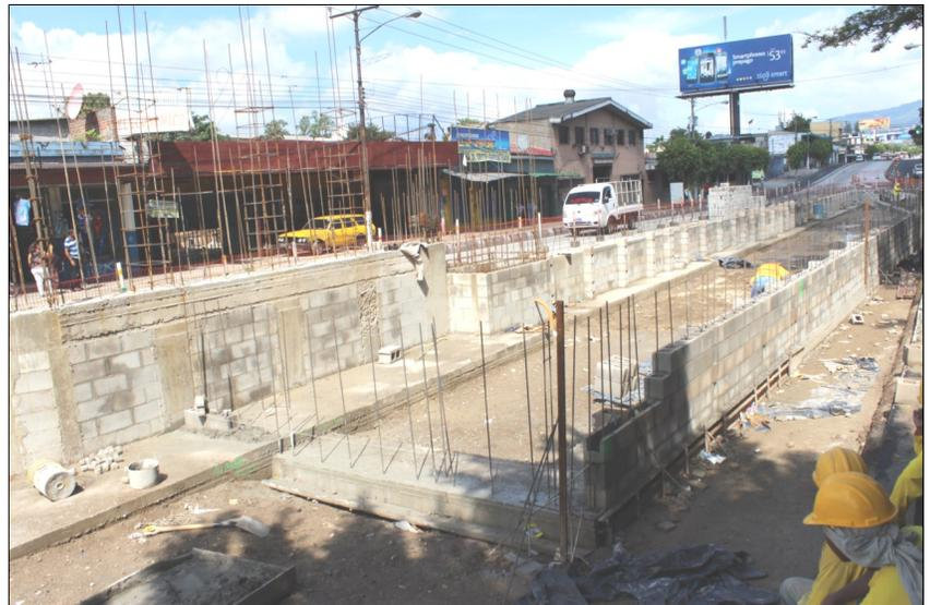
La Estación Parque Centenario muestra avance en paredes y el tótem de la estructura, falta lleno y compactado, para seguir con el colado de concreto hidráulico.
