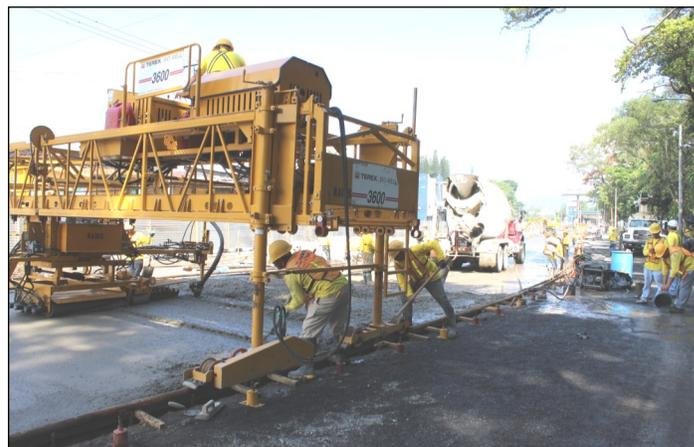
Obreros de ASTALDI trabajando en el colado de concreto hidráulico del carril segregado de la Estación de Autobús del Parque Infantil.
