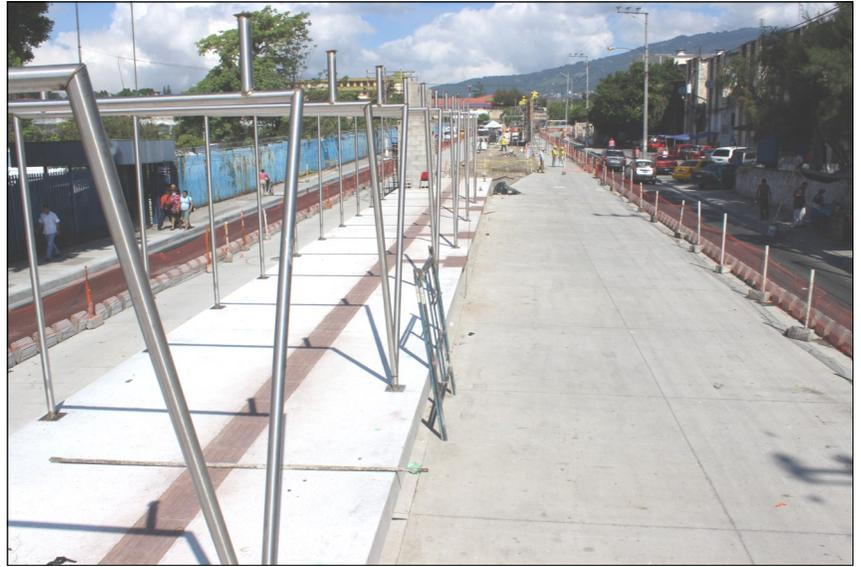
Estación del Hospital Médico Quirúrgico es la estructura que tiene mayor avance, ya muestra estructura de acero inoxidable donde irán los techos y paredes.
