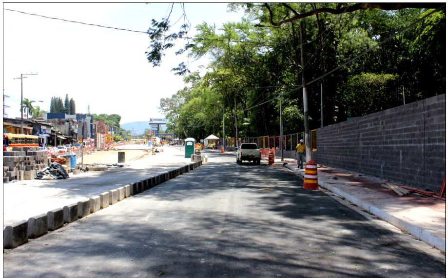
Se construyeron 2 carriles de asfalto, en frente del Parque Infantil y el carril segregado a la izquierda de la fotografía; avance constructivo hasta el 4 de julio de 2014 es de 50.14%.
