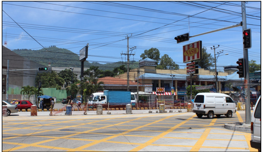
Intersección de la Avenida El Rosario Sur y el Bulevar del Ejército en Soyapango, ya cuenta con el sistema de semáforos que coordinarán el tráfico vehicular y peatonal.
