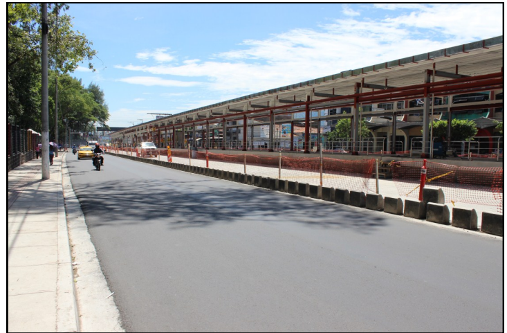
La estación de autobuses ya tiene techo, lleva un avance constructivo del 85.70%, se construyó la pista de concreto y dos carriles grises para la circulación del tráfico particular.
