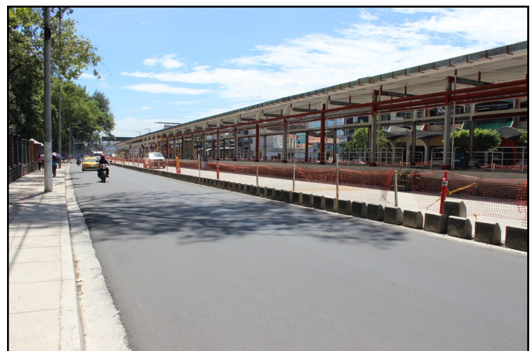
Estación de autobuses del Parque Infantil tiene un avance del 97.30%
