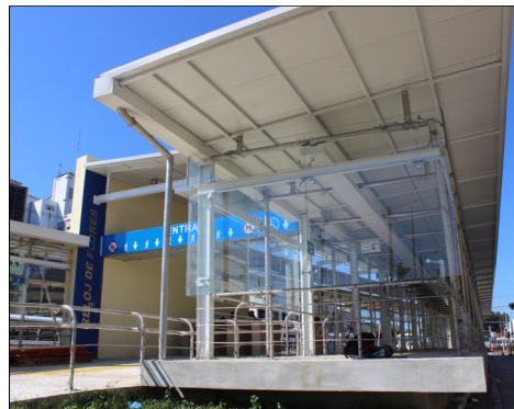
En la gráfica la Estación Reloj de Flores construida con concreto hidráulico en su base, la superestructura con acero inoxidable, techo de zinc alum y las paredes de vidrio templado.
