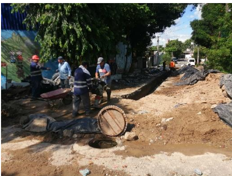
Supervisión Proyecto Reparto Apopa colocación de tuberías aguas lluvias.
