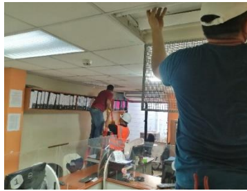
Seguimiento a Alumbrado Público colocación de Tubos LED en Diferentes oficinas del Edificio Municipal.
