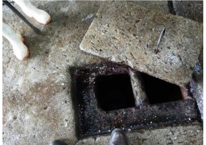
Fotografía 1 – Canaleta de drenaje, caja central del Rastro y cesta colectora en pozo equalizado de Planta de Tratamiento de Aguas Residuales (PTAR).
