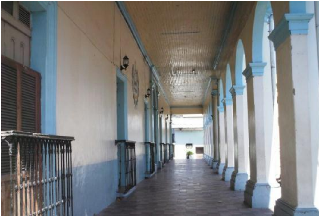
FOTOGRAFIA N° 2: vista de uno de los portales de la alcaldía municipal de Chalatenango
