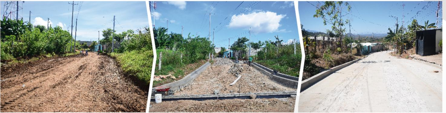
Construcción de fajas de concreto y empedrado fraguado en pje N° 3 de lotificación la Gramita
