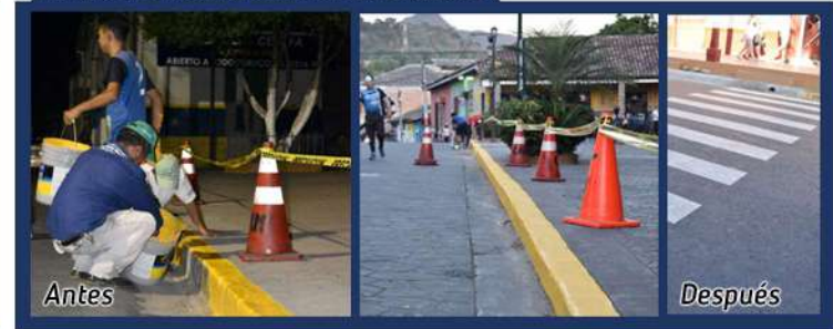
Ornato, señalización y mantenimiento de portales.
