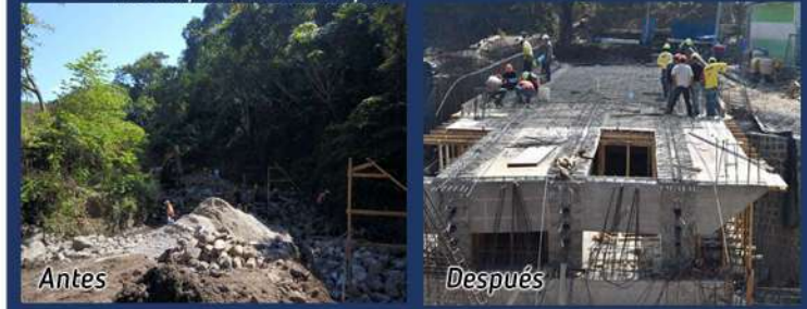
Construcción de puente vehicular sobre Rio Chiquito, Crio. El Chuptal
