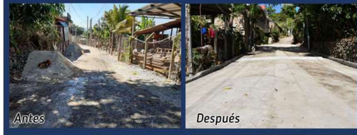
Construcción de fojas de concreto en tramo de Calle a la Chácara.
