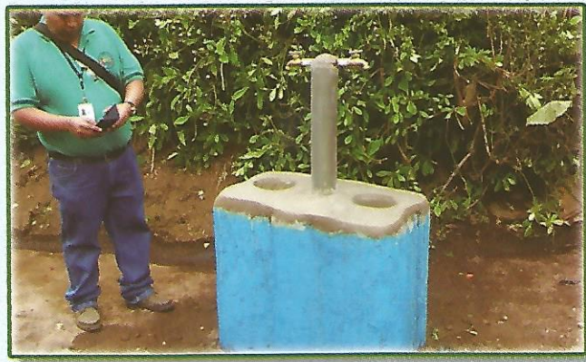
Introducción de Agua Potable y construcción de cantarera en Rastro municipal
