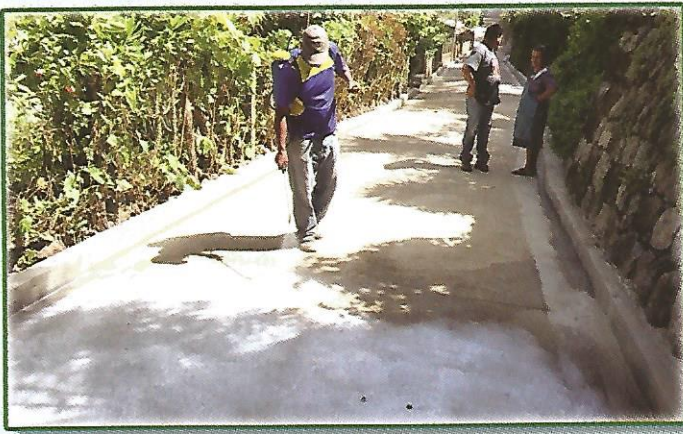
Concreteado Hidráulico en tramo de Calle de Barrio San Juan
