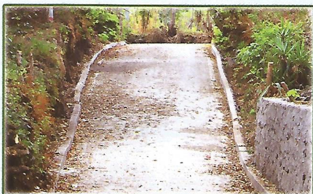
Empedrado Fraguado de calle en Caserío Mama Lola, Cantón Conacastal
