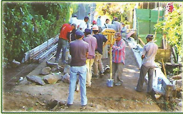
Concreteado Hidráulico de calle en 4a Calle Poniente, Barrio El Calvario
