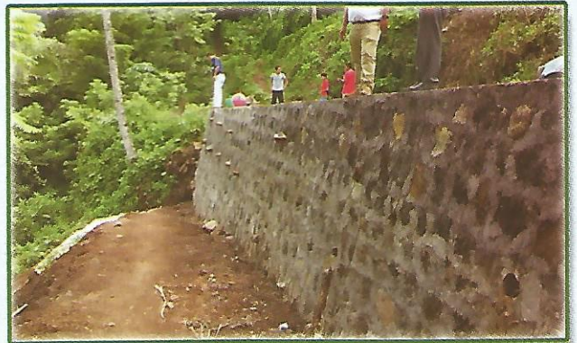
Construcción de Muro de retención en Lotificación El Mameyal (FUNDAGEO)
