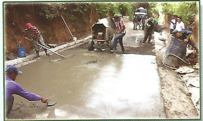
Concreteado Hidráulico de tramo de calle en Cantón Cruz Primera
