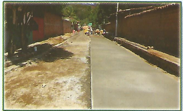
Concreteado Hidráulico en Final 9a Calle Oriente , Barrio Nueva España
