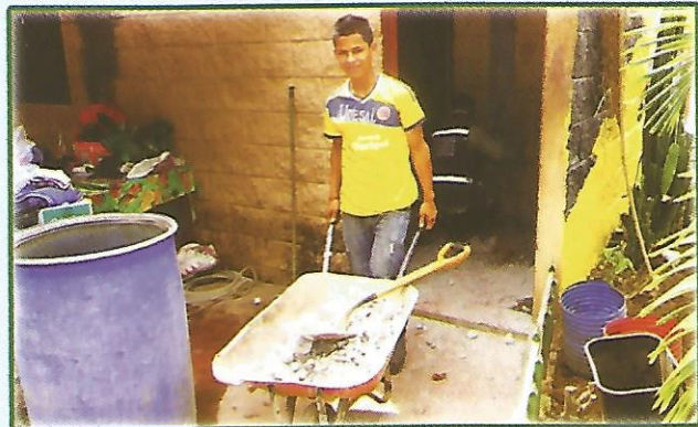
Remodelación de baños municipales en el Parque Municipal
