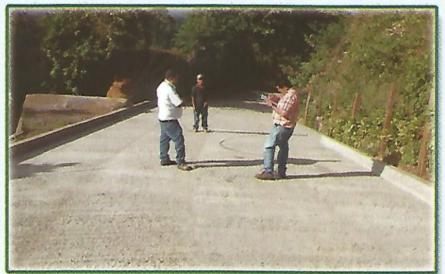
Concreteado Hidráulico de Calle en Cantón Jocote Dulce
