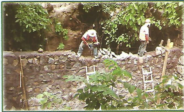
Construcción de Muro de retención en 3a Av. Norte, Frente a PROMERCA, Barrio Dolores
