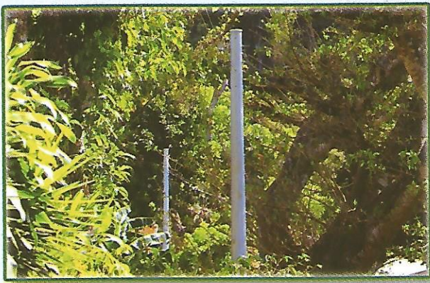
Introducción de Energía Eléctrica en Cantón Copinol II
