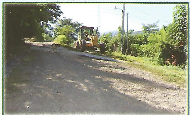
Conformación y Balastado de Calles en Colonia Esmeralda I y II
