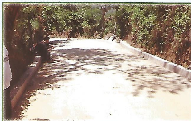
Empedrado Fraguado de Calle en Cantón Ojo de Agua
