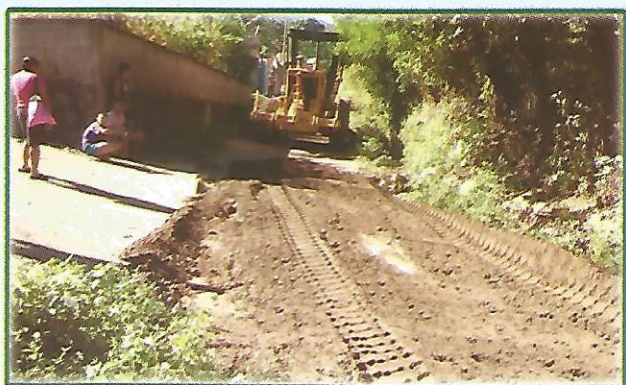
Conformación y Balastado de Calles en Caserío Santa Lucía
