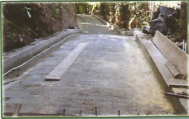
Concreteado Hidráulico en Final 5a Av. Norte, Barrio El Calvario
