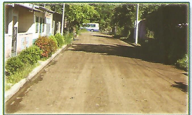
Conformación y Balastado de Calles en Lotificación La Torre
