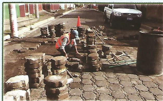
Reparación y Bacheo de Calles en diferentes puntos de la Zona Urbana del municipio
