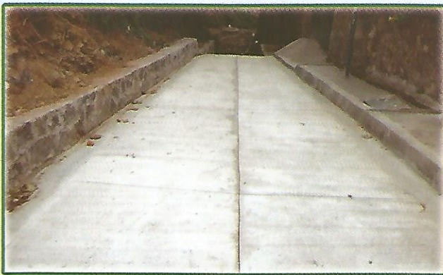
Concreteado y Gradas en Final 8a Calle Poniente, Barrio El Calvario
