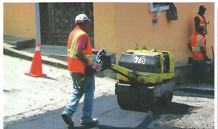
Conformación y Bacheo Rutinario con Mezcla Asfáltica en Calles Principales de Barrio El Calvario, Barrio Yusique y Barrio Dolores
