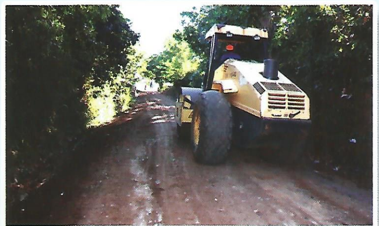
Balastado y compactado de 825 mts. Lineales en calle principal del Caserío Los Hernández, Cantón Las Mesas MONTO $24,347.01
