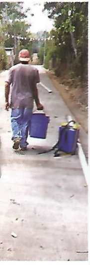
Inicio de tramo de la Iglesia Católica calle pavimentada, (12 mts. Lineales) MONTO $6,134.89
