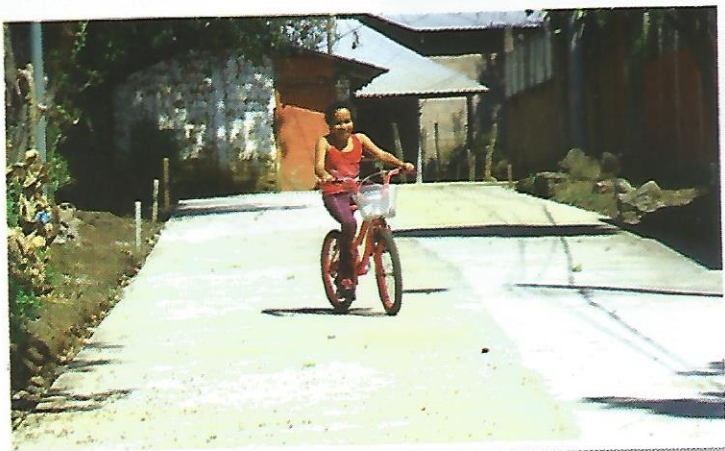
Construcción de Concreto Hidráulico en la entrada de la 3a. Calle Poniente, en 2a. Av. Norte, Barrio Nueva España (153.42 mts. Lineales)
