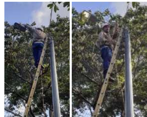
REPARACIÓN LED, OJO DE AGUA
