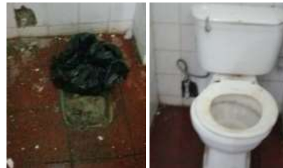
REPARANDO SANITARIO DAÑADO, ESTADIO MUNICIPAL
