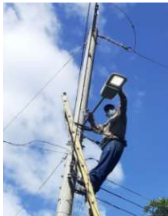
REPARANDO LUMINARIA LED, CANTÓN COPINOL SEGUNDO
