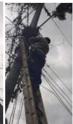
REPARANDO LUMINARIA LED, EL CASTEL
