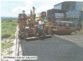
[REPARACIÓN DE CALLES]
