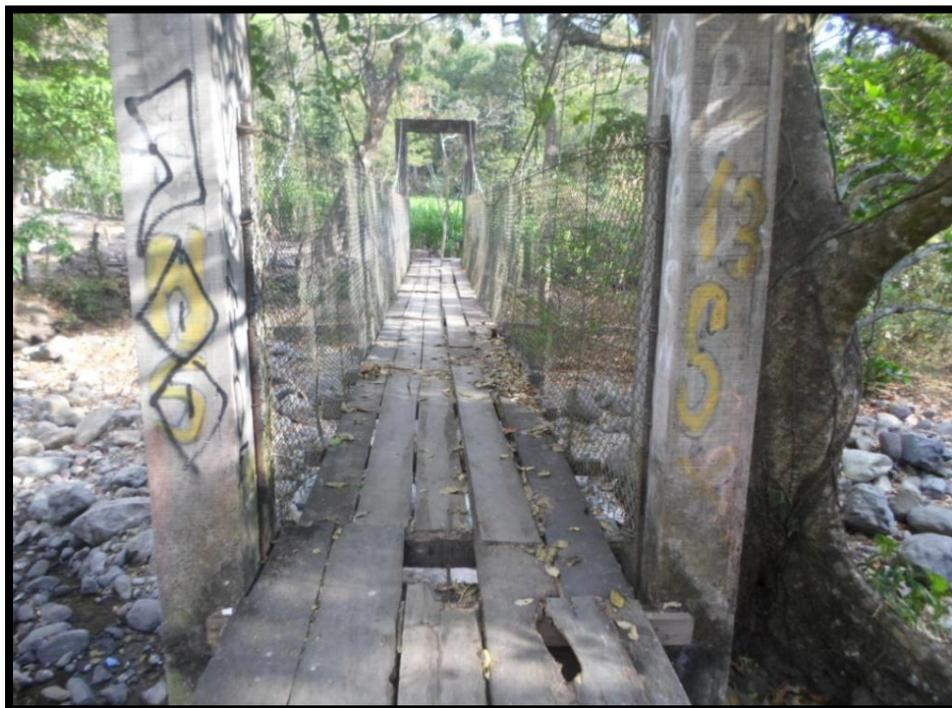
Figura 22. Estado actual del puente hamaca que comunica el Área Urbana con el Cantón Candelaria
