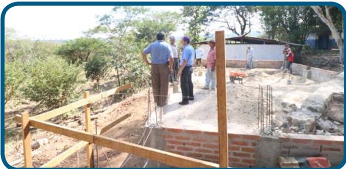
2 aulas de 7.60 metros de largo por 7.20 metros de ancho y un corredor de 2.40 metros, techadas con lámina duradera y resistente.
