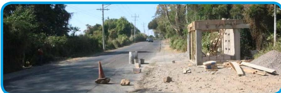
La construcción de estas paradas de buses medirán 4 metros de longitud, 2.50 de ancho y 3.20 de altura vista.
