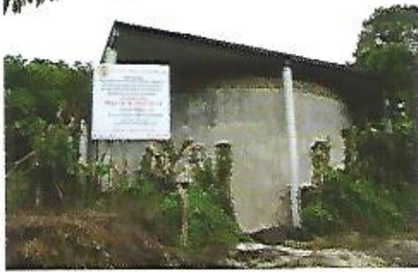
Reconstrucción de la estructura y cubierta de techo del tanque de almacenamiento de aguas lluvias, caserío Ramírez, San Jerónimo Los Planes.
