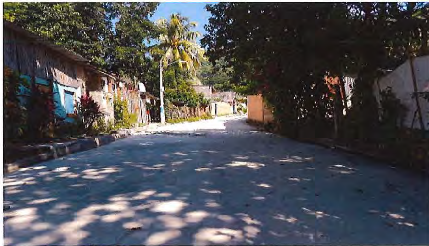
Imagen 4. Vista general del proyecto desde Est. 0+035.00 muestra el buen estado de la capa de rodadura al momento de recepción del proyecto.
