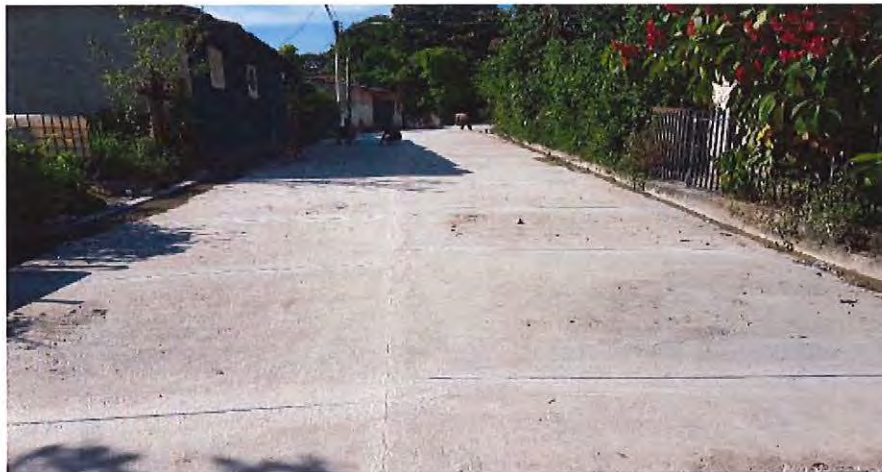
Imagen 2. Vista general del proyecto desde Est. 0+110.00 muestra el buen estado de la capa de rodadura al momento de recepción del proyecto.
