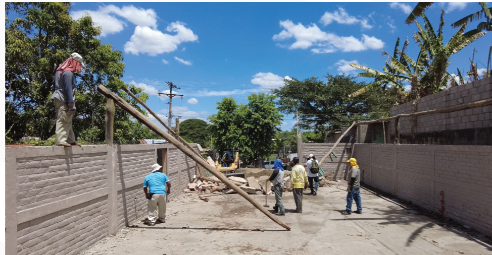
Construcción Casa Comunal de Mapilapa.
