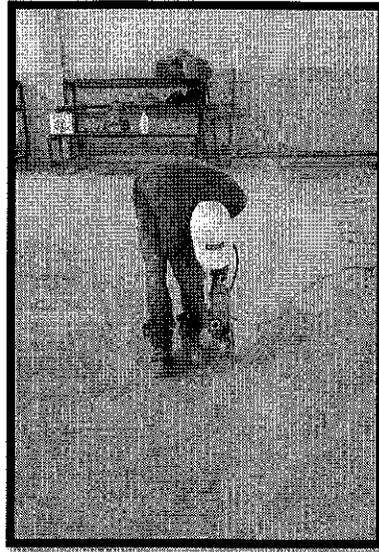
Imagen No 7 – Corte de juntas de dilatación.
