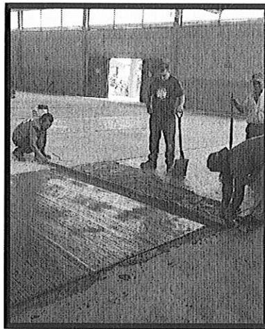
Imagen No 15 – Colocación de mortero.
