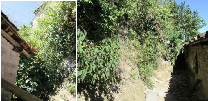
Fotografías que muestran el cambio de nivel y la construcción de casas en la parte alta del sector conocido como El Rastro, Casco Urbano (Fotografías: Noel Isai Chica).
