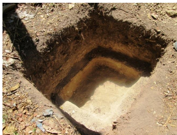
Izq. Capa de la nominada TBJ (tierra blanca joven) que ha sido labrada y ahora constituye media pared del corredor de una vivienda. Der. Perforación para la construcción de una letrina de fosa en la que se pueden diferenciar el estrato superficial y la TBJ en el Casco Urbano de San José Guayabal (Fotografías Noel Isai Chica).
