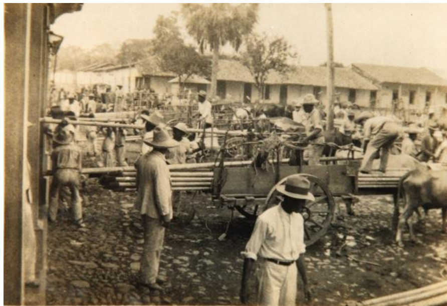
Instalación de la primera tubería para el sistema de agua potable de San José Guayabal ( Fotografía: Alcaldía Municipal de San José Guayabal ).
