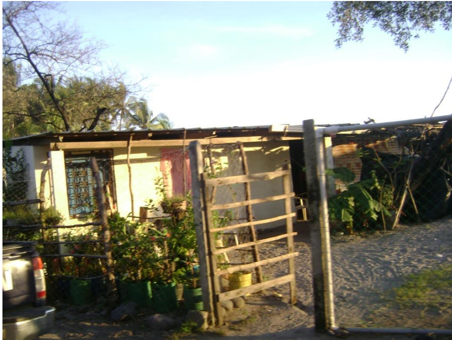
Figura 2: Vivienda ubicada cerca de la bocana del río Jiboa; de construcción mixta: ladrillo, hierro y lamina.
