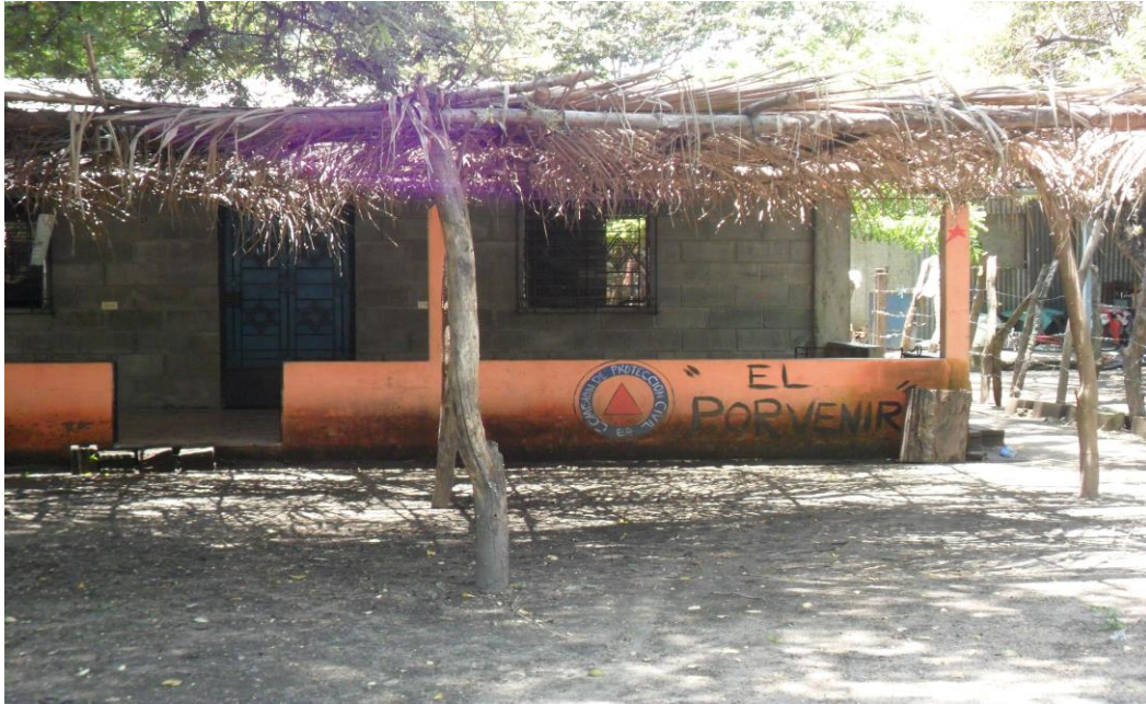
Figura 1 : Sede de Protección Civil El Porvenir.
