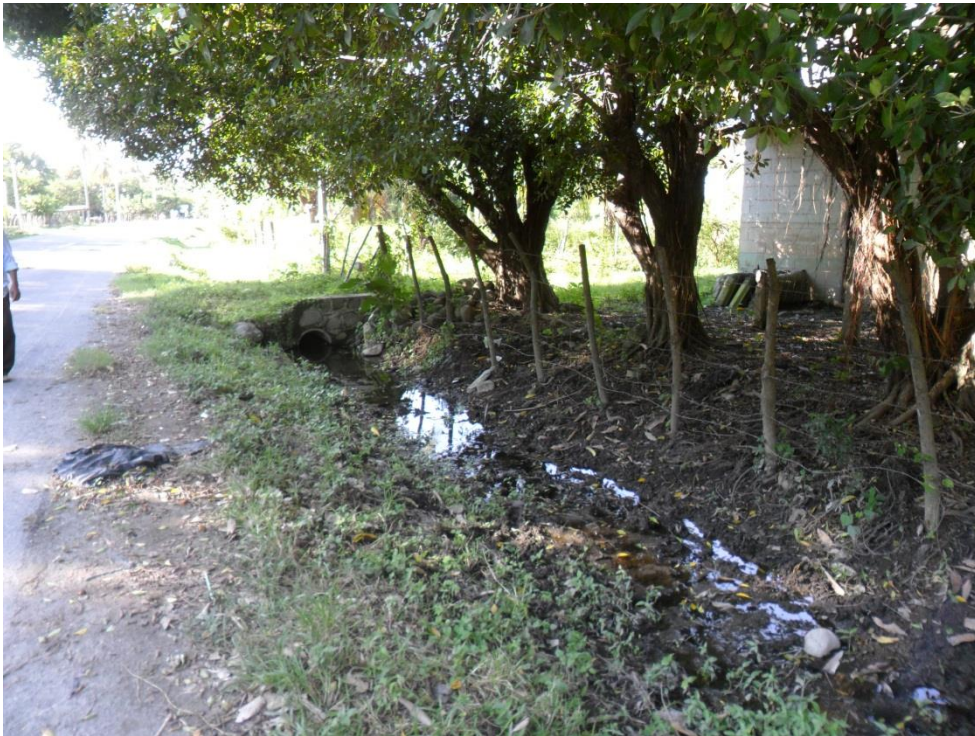
Figura 4: Canaletas en el caserío de Santa María El Coyol que en tiempo de invierno se saturan de agua causando inundaciones.
