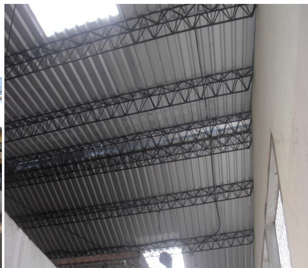
REPARACIÓN DE TECHO SECTOR ROPA
