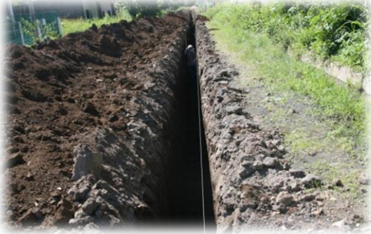
Proyecto introducción de aguas negras urbanización Cuscatlán monto $ 74,194.79
