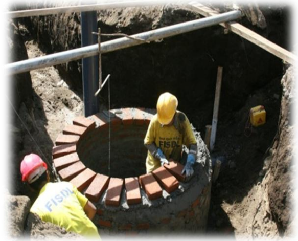
Proyecto introducción de aguas negras colonia san Gerardo se invirtieron $127,968.68
