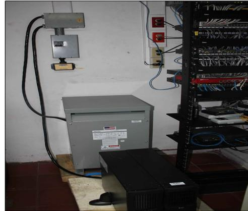
Instalación de Supresor de Transientes para evitar el daño a equipos por sobre cargas eléctricas, este fué colocado a la entrada de la acometida eléctrica del centro de datos.
