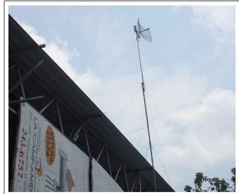
Antena Wifi que transporta comunicación de telefonía fija y red de datos en plantel de Aseo.
