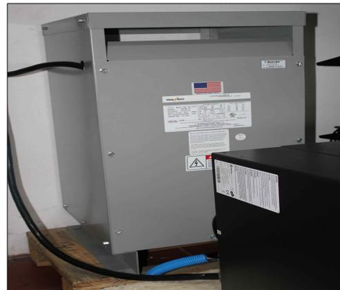
Instalación de UPS central y Transformador 220 V. para fallas del suministro de energía eléctrica y así los servidores continúen funcionando (si la suspensión del servicio eléctrico no es mayor de 20 min.)
