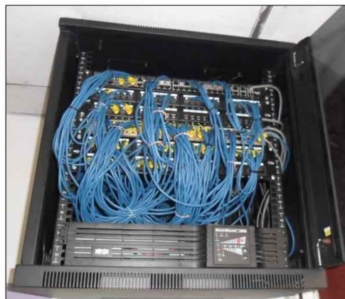
*Gabinete de Red, conexiones Antes y Después, permite la identificación de todos los puntos de red.*
