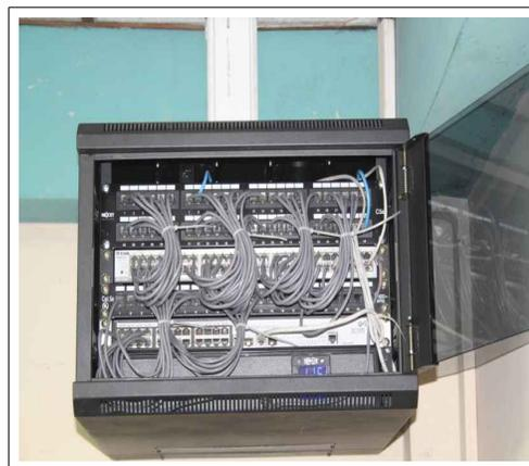
Gabinete, Switch Power Over Ethernet para 48 puertos o estaciones de trabajo, con UPS.
