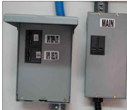
*Instalación de Cajas Térmicas para realizar la distribución de UPS en Centro de Datos*
