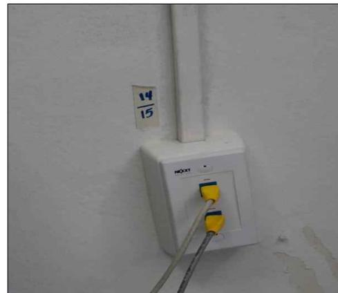
*Todos los puntos de red se colocarán en ductos, canaletas y en cajas de montaje.*
